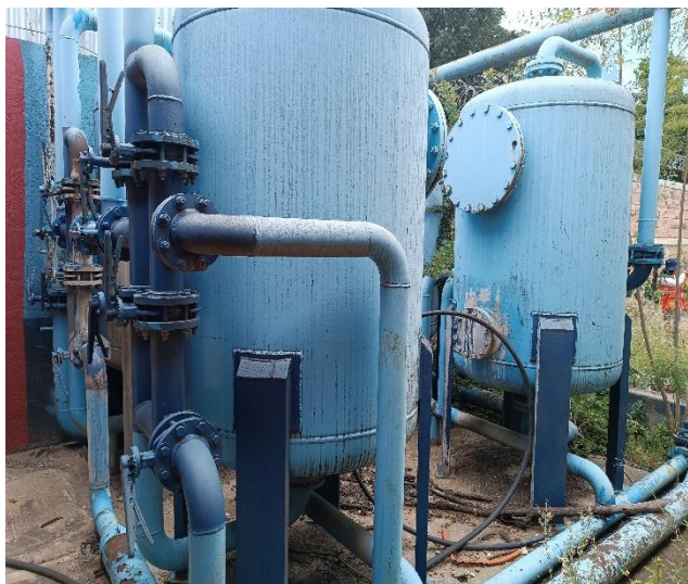
IMAGEN 1. VISTA DEL TREN DE DESCARGA DEL POZO EXISTENTE. AL FONDO SE APRECIAN LAS PLANTAS DE TRATAMIENTO A PIE DE POZO, LAS CUALES ESTÁN CONSIDERADAS PARA SU RETIRO COMO PARTE DE LOS TRABAJOS DE REPOSICIÓN.
