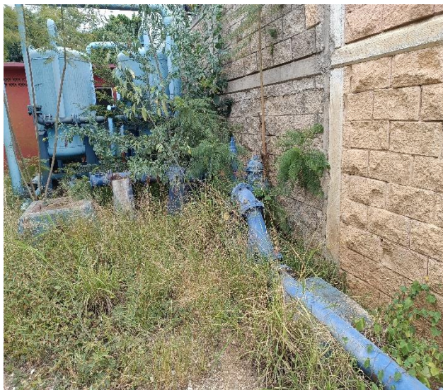
IMAGEN 1. VISTA DEL TREN DE DESCARGA DEL POZO EXISTENTE. AL FONDO SE APRECIAN LAS PLANTAS DE TRATAMIENTO A PIE DE POZO, LAS CUALES ESTÁN CONSIDERADAS PARA SU RETIRO COMO PARTE DE LOS TRABAJOS DE REPOSICIÓN.
